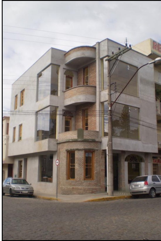
Figura 5 Construção de um prédio comercial no local (Maio/2012)
