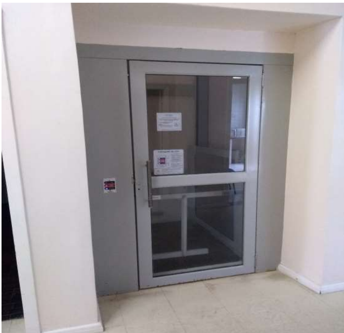
Fotografia 3 - Elevador de acessibilidade
