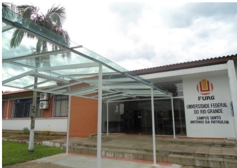
Figura 16 – Uma cobertura translúcida foi construída para proteger o acesso principal à edificação.
