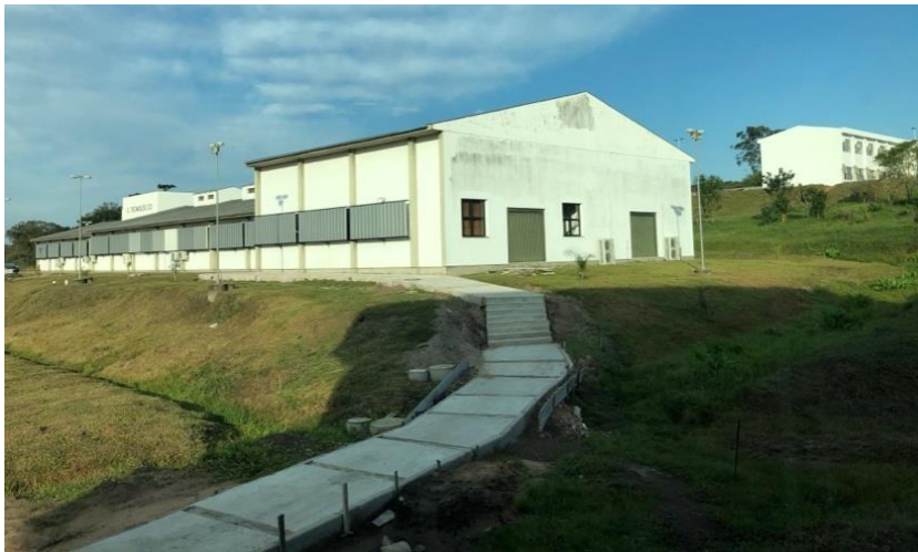
Figura 100 – Finalização de calçada em 2020 permitiu o acesso entre o Centro Tecnológico e o prédio administrativo na Unidade Bom Princípio.
