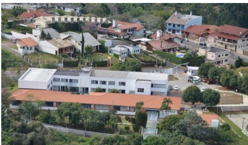
Figura 15 – A antiga escola Barão do Cahy recebeu uma nova cobertura com telhas de barro e a construção, em duas etapas, de um anexo com dois pavimentos para receber os laboratórios de Química e Física e almoxarifado.
