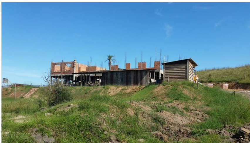
Figura 51 – Construção da Casa de Estudantes.
