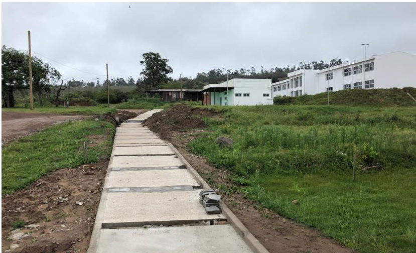
Figura 101 – Calçada concluída em janeiro de 2020 facilitará o acesso entre o Centro Tecnológico e o Ponto de Convívio na Unidade Bom Princípio.
