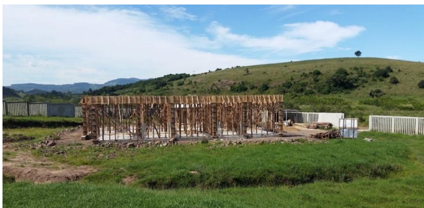
Figura 50 – Início da construção do prédio administrativo em 2015.
