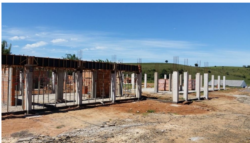
Figura 52 – Construção do pavilhão de salas de aulas.
