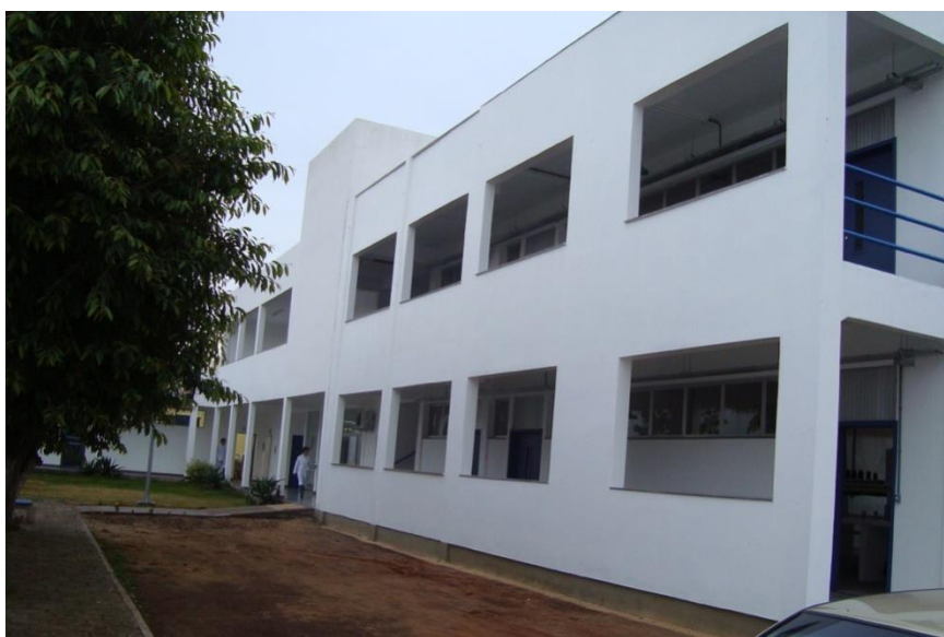
Figura 12 – Conclusão do prédio destinado aos laboratórios de Química.
