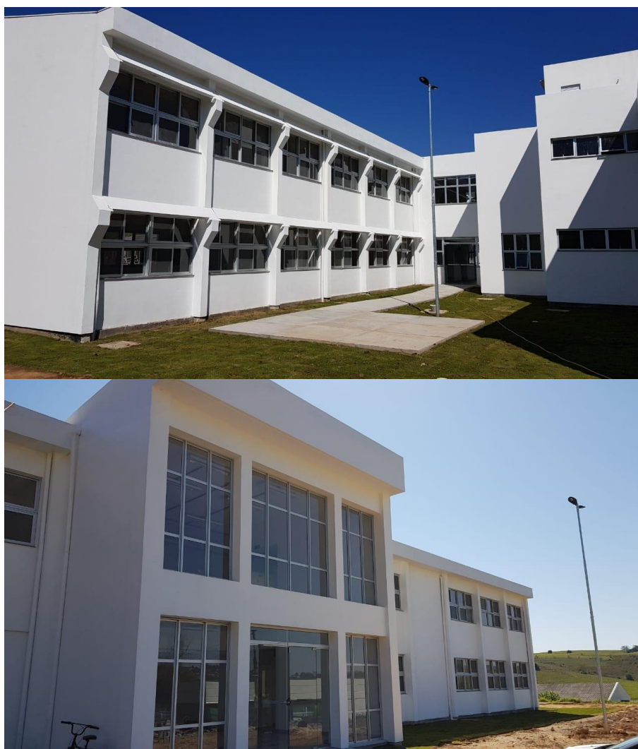
Figura 170 – Pavilhão de salas de aulas da UBP.
