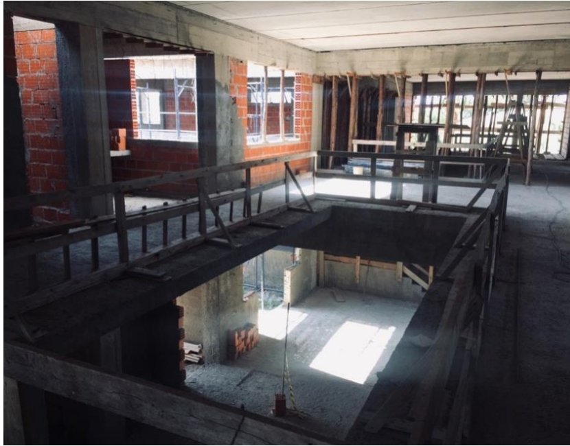
Figura 77 – Obras do pavilhão de salas de aulas foram retomadas também em 2018.
