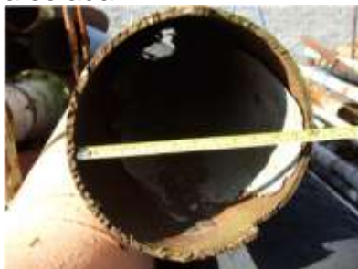
FIGURA 7.22 – Tubo da caixa selada
