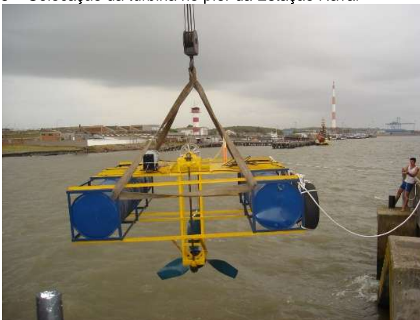
FIGURA 6.28 – Colocação da turbina no píer da Estação Naval
