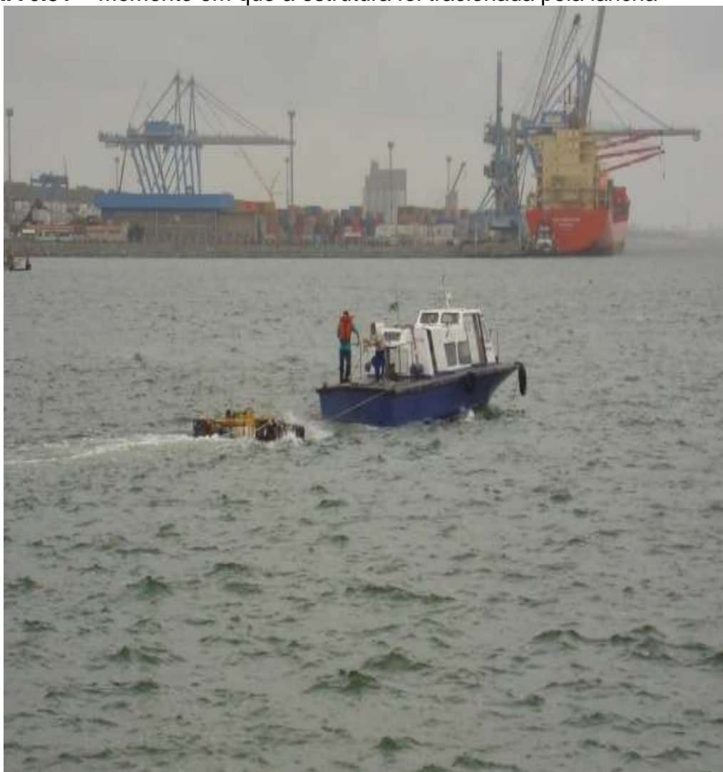
FIGURA 6.31 – Momento em que a estrutura foi tracionada pela lancha
