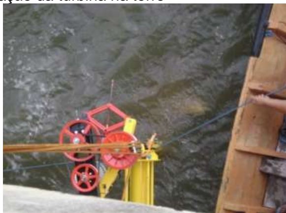
FIGURA 7.68 – Instalação da turbina na torre
