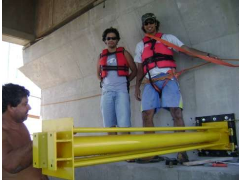
FIGURA 7.66 – Torre da turbina instalada
