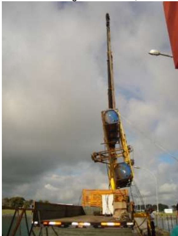
FIGURA 6.32 – Retirada da estrutura da Lagoa dos Patos, sem o rotor
