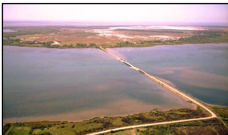
Figura 4.27- Acesso a Ilha dos Marinheiros pela ponte nova (Fonte: Rio Grande em Fotos 2006).
