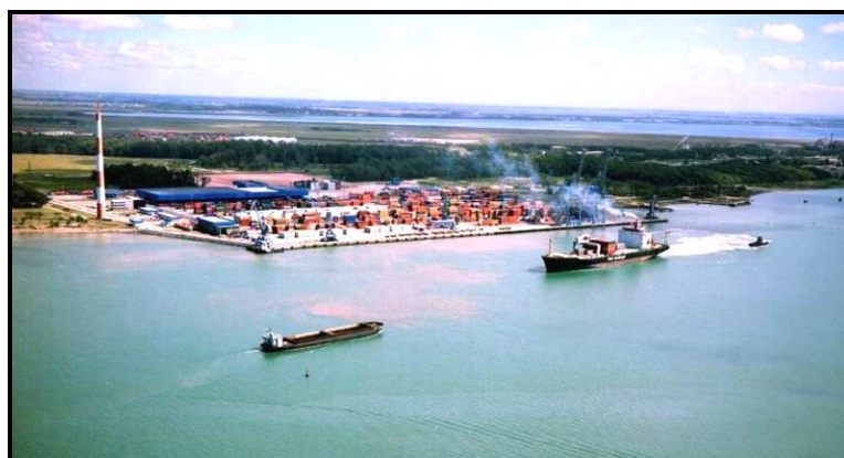
Figura 4.14-Superporto de Rio Grande, vista do Tecon. (Foto: Aílton Ávila da Rosa).
