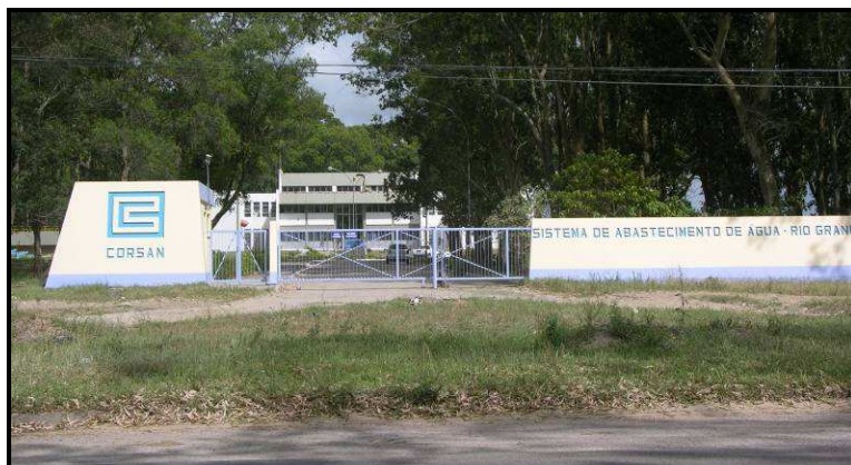
Figura 4.30- Estação de tratamento de água da Corsan.
