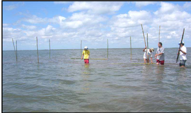
Figura 2.20- Marcação do local de instalação do cercado.
