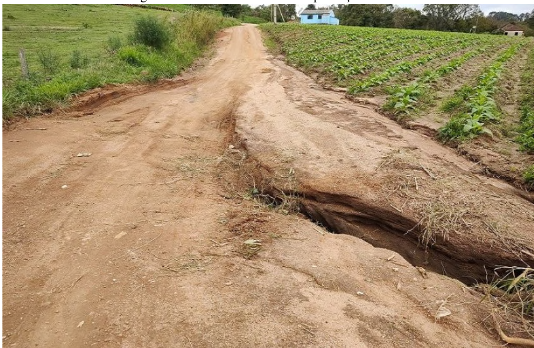
Figura 58 - estrada do Bonito/RS e plantação de fumo
