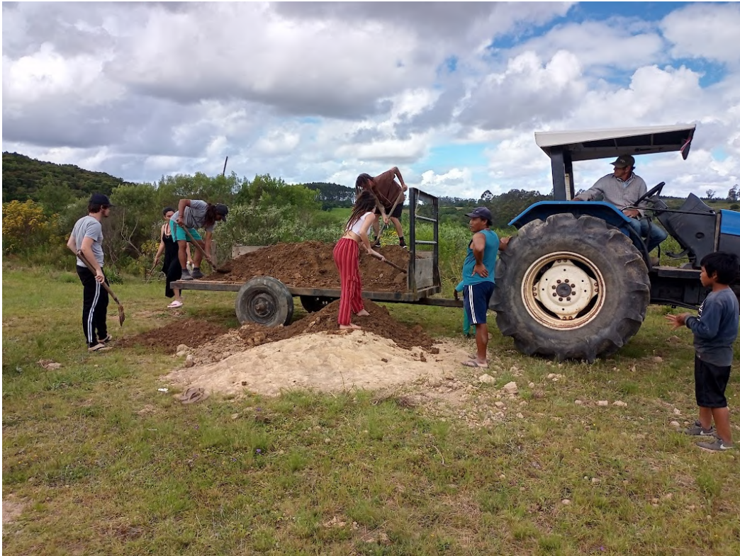
Figura 59 - transporte da terra até o local do barreamento
