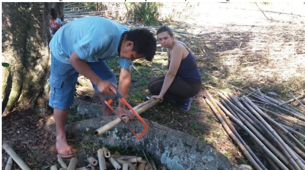
Figura 33 - corte de taquaras para construção de domo geodésico
