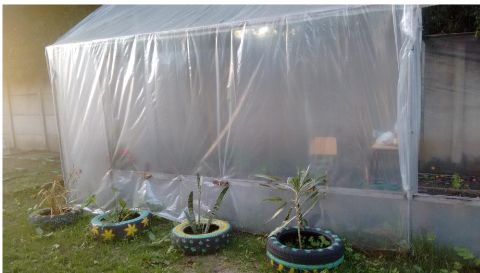
Figura 10: Estrutura de Estufa Fonte: Acervo do autor
