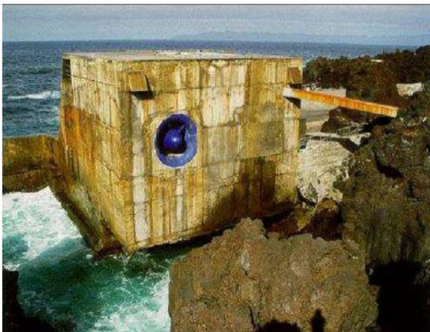
Figura 1.4-Central Piloto instalada em Portugal (CRUZ E SARMENTO, 2004)
